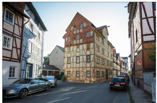
Historisch gewachsene Baustrukturen aus der Gründerzeit
