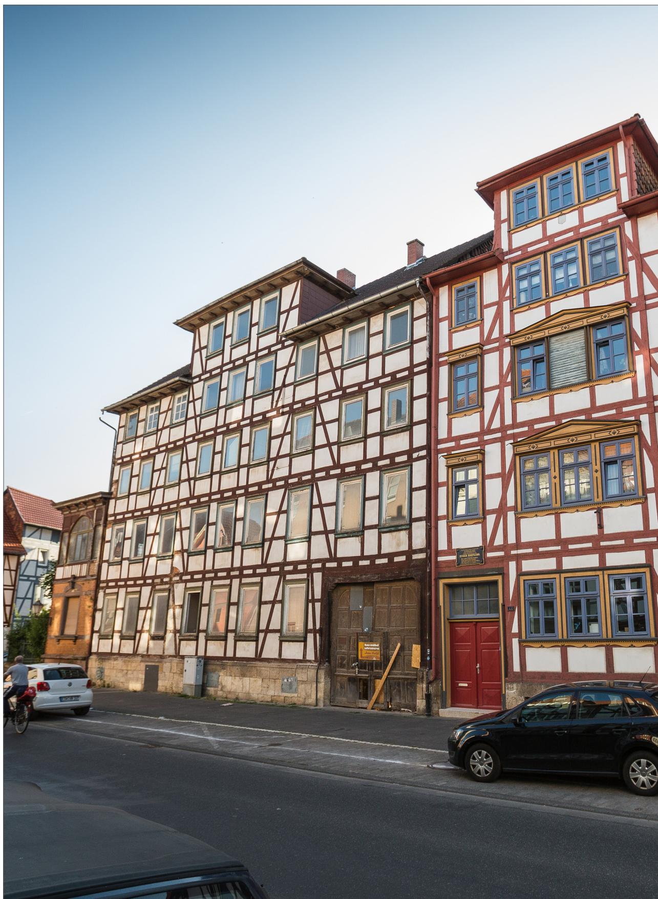
Historischer Fachwerkbestand in der Brückenstraße
