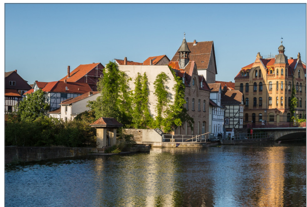
Bauliche Befestigung der Uferbereiche an der Werra
