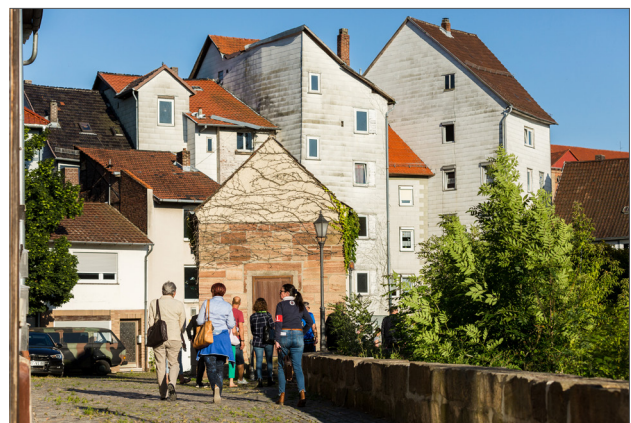
Abgängige rückwärtige Bebauung in Brückenhausen
