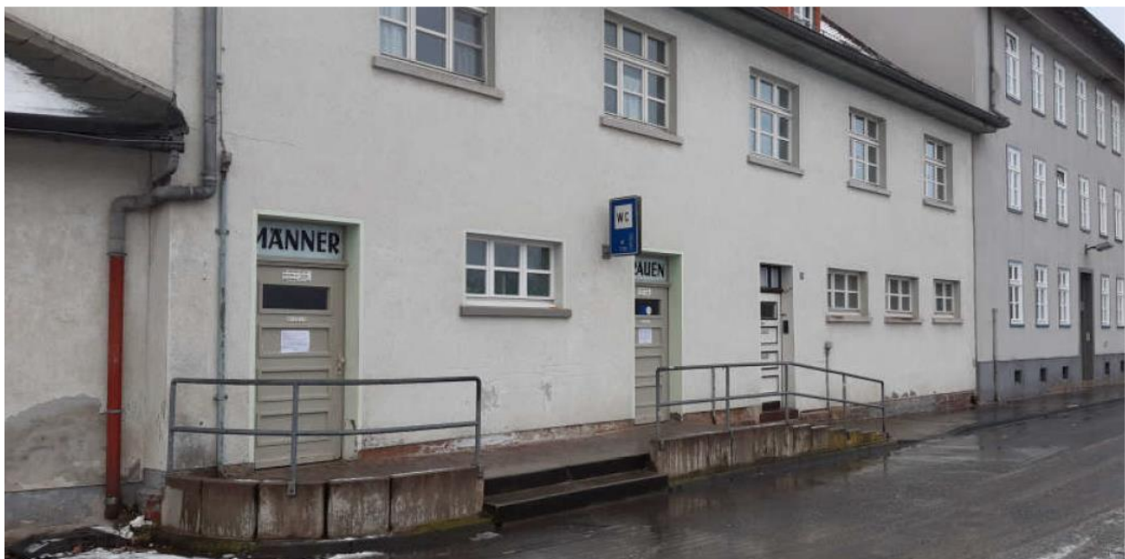
Ansicht Nord, aktuelle Zugangssituation
