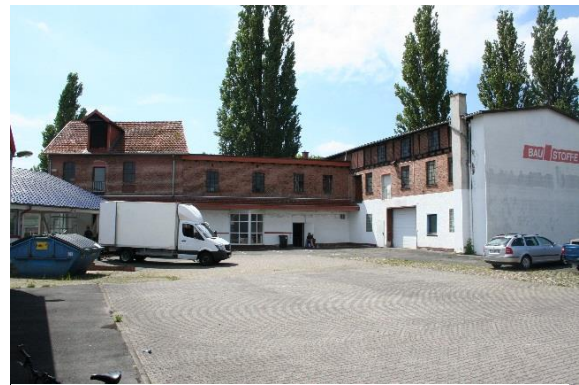
Untergenutzte Lagerhäuser am Eschenweg
